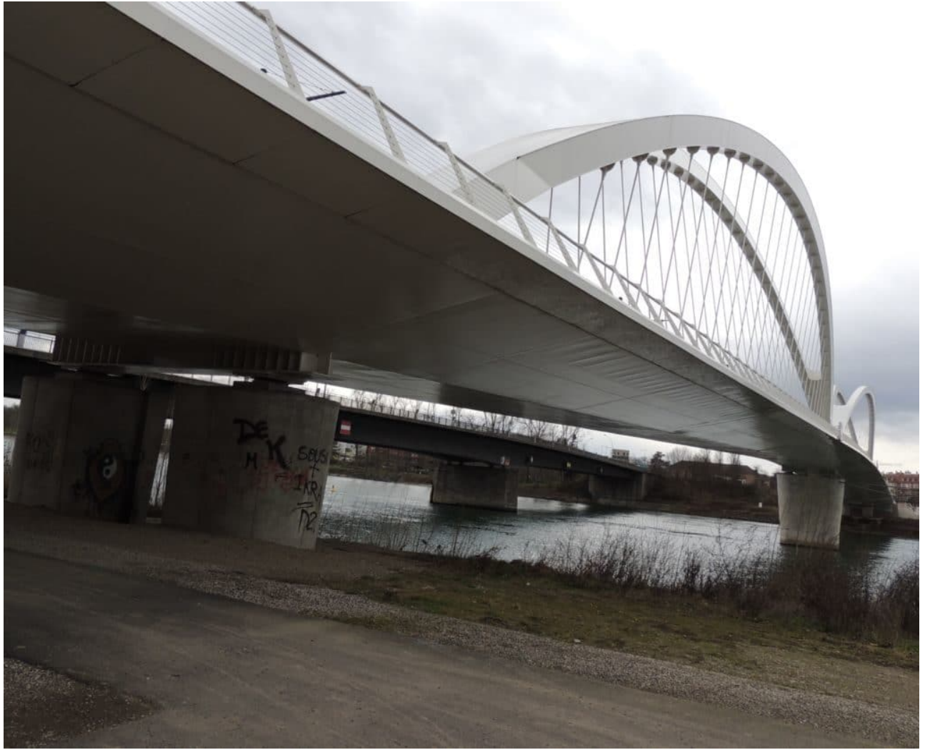
• Trambrücke Februar 2019 - Foto(bea)
