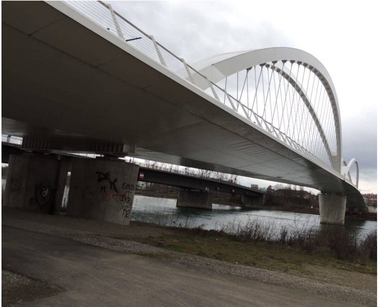
• Trambrücke Februar 2019 - Foto(bea)
