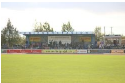
Tribüne des Friesenstadions Sangerhausen_Foto: sas
